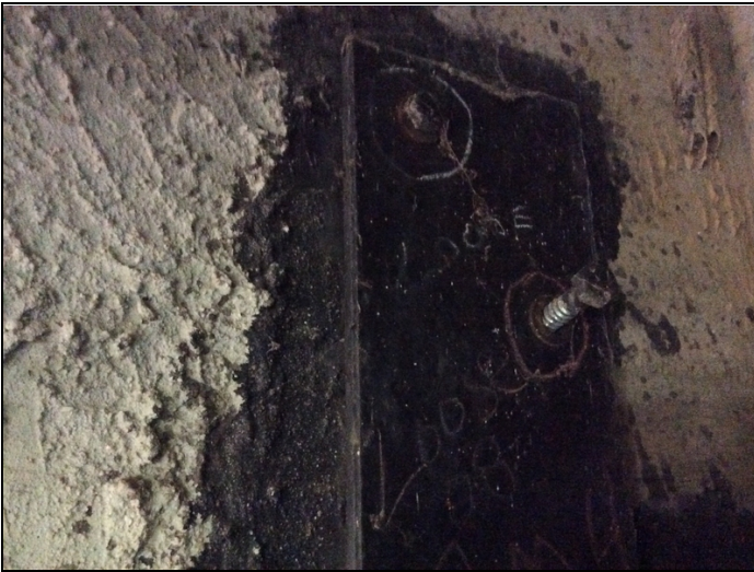
Span # 1, girder # 3- loose bolt.
